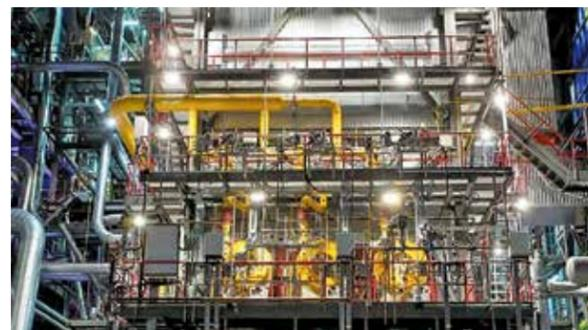
На Юго-Западной ТЭЦ окончено строительство третьего водогрейного котла, его мощность — 120 Гкал/ч — в два раза превышает мощности каждого из двух ранее установленных на станции котлов по 60 Гкал/ч. Новый котел полностью российского производства и стал первым оборудованием на станции, управление которым осуществляется АСУ ТП российского производства. Длительность экскурсии составит 40–60 минут.
